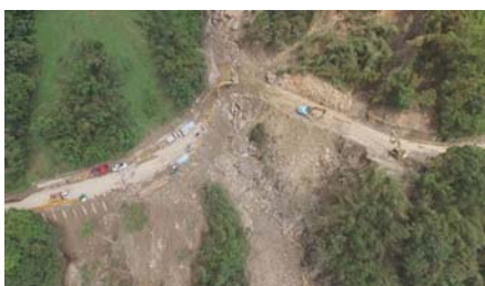
105年 蘇迪勒 颱風造成新北烏來地區嚴重坡地崩塌
